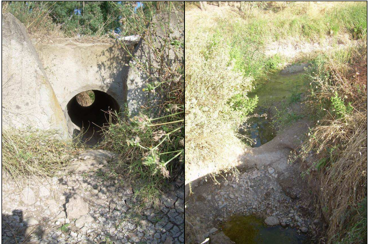
Figura 4-11: tratto intubato e tratto a valle dell'opera di attraversamento dell'affluente di destra alla confluenza con il corso d'acqua principale.
