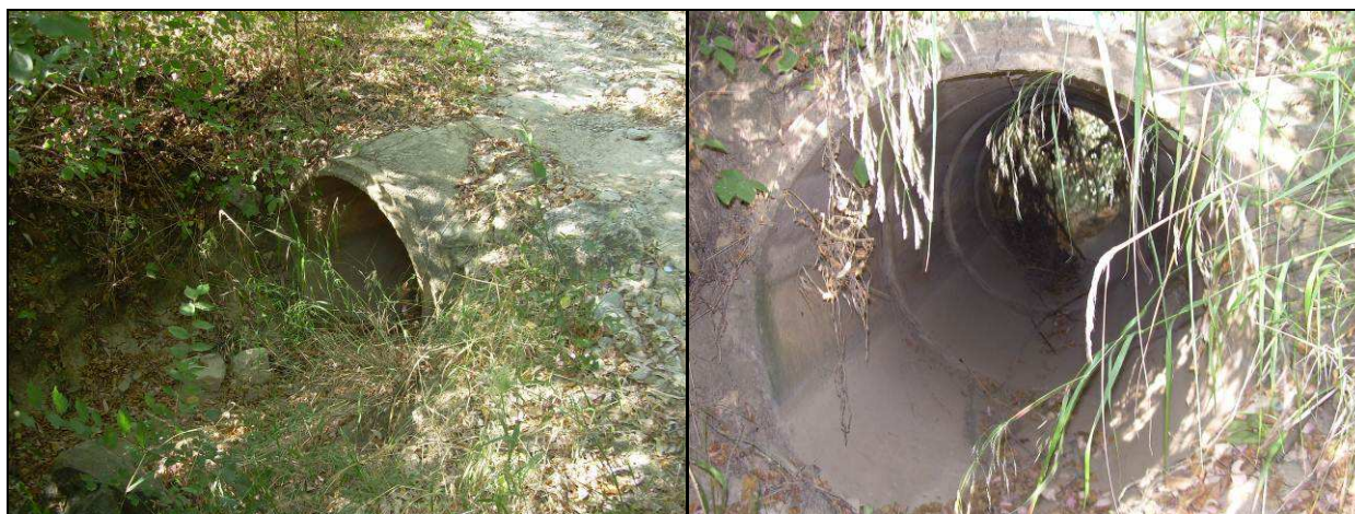
Figura 4-8: tratto intubato immediatamente a valle del ponte sulla strada comunale.
